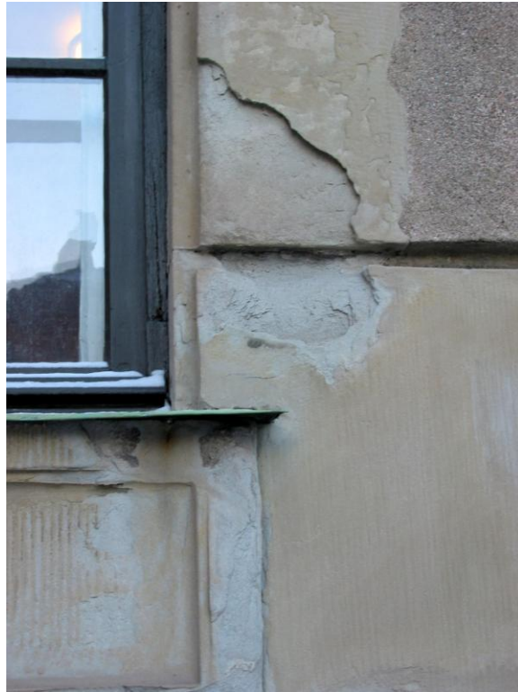
Bild nr. 1. Sandning och exfolieringsskador observerade på Stockholms slott.
