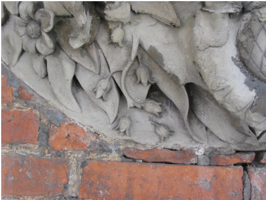
Bild nr. 2. Sandning på ytor utsatta för regn, svart krusta på regnskyddade ytor samt mikrosprickor. Detalj av stengirlang på Riddarhuset.
